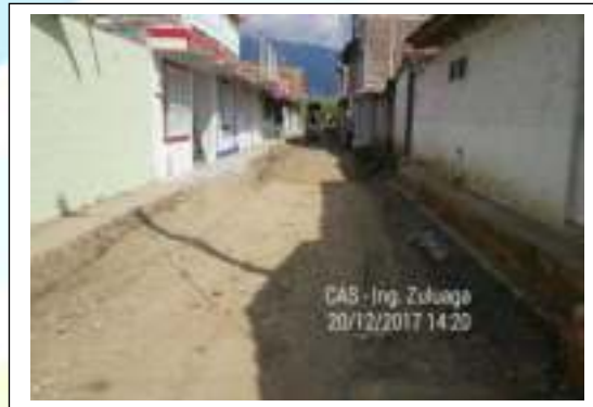
Adecuación temporal de vía con el vibrocompactador
