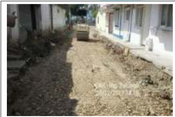
Adecuación temporal de vías intervenidas, con roca muerta compactada
