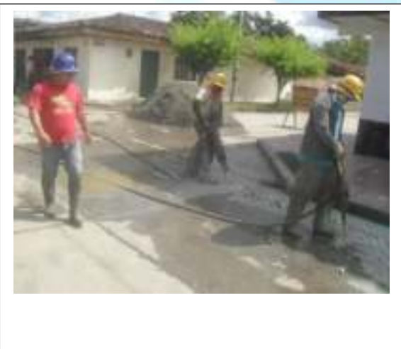
Demolición de pavimento
