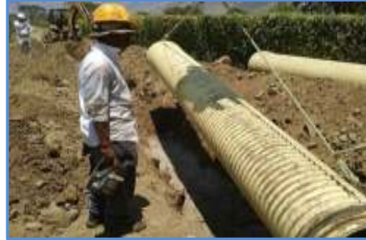
PROCESO DE INSTALACION COLECTOR DE ALCANTARILLADO
