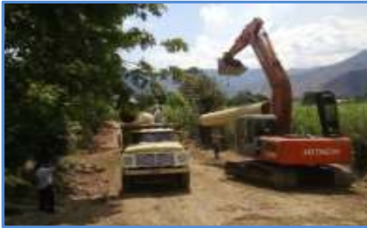
TRANSPORTE DE TUBERIA PARA SU RESPECTIVA INSTALACION
